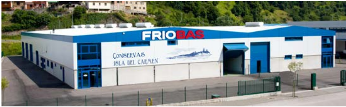
Instalaciones de Friobas en Asturias.
