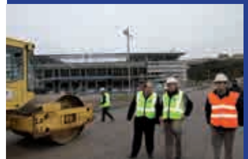
Las obras en la calle Bernardo Casielles suponen una importante mejora en las comunicaciones de la zona del Tartiere.
