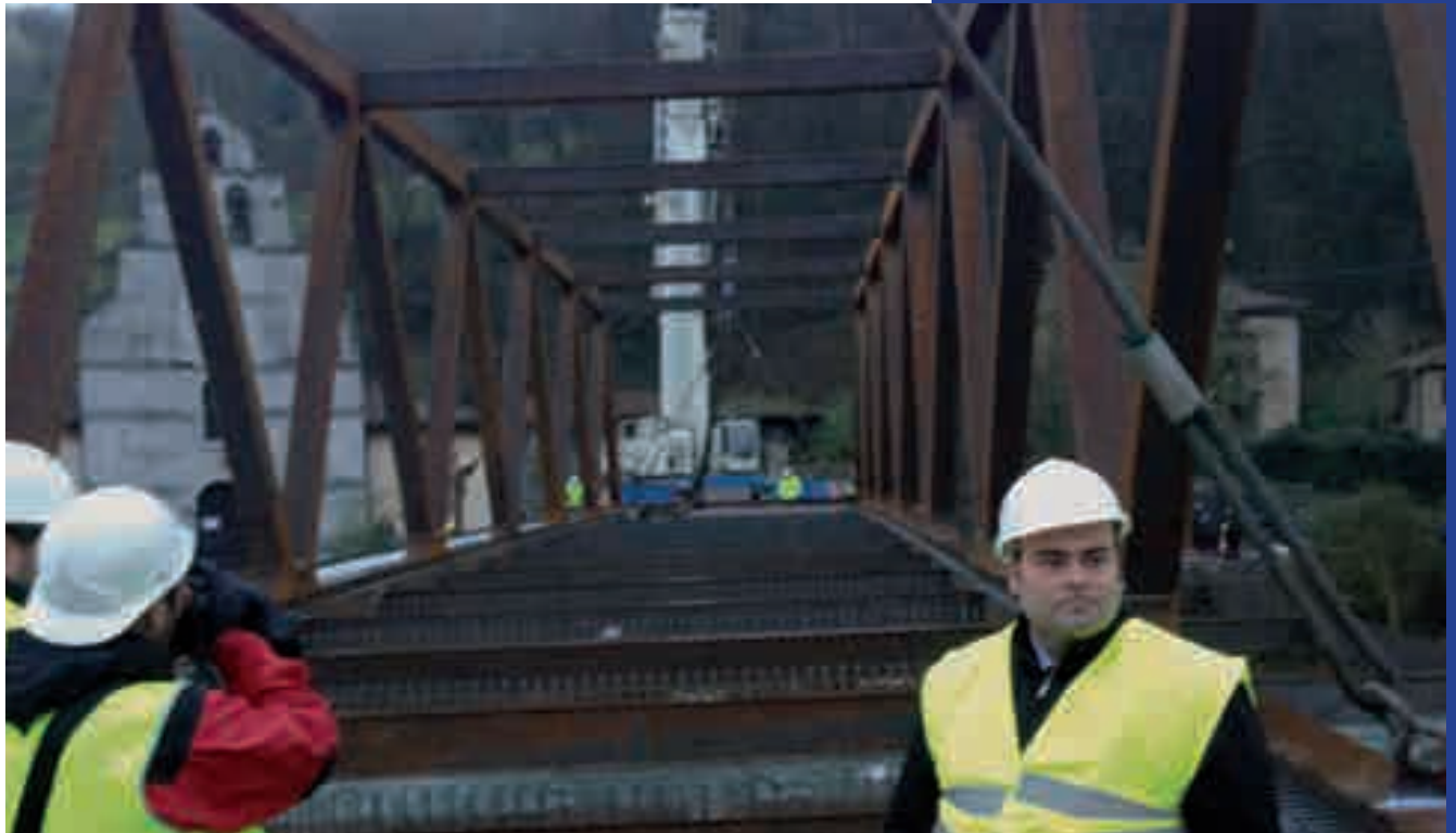
La construcción del puente de La Riera tras las inundaciones fue una de las primeras obras del mandato de Agustín I. Caunedo.
