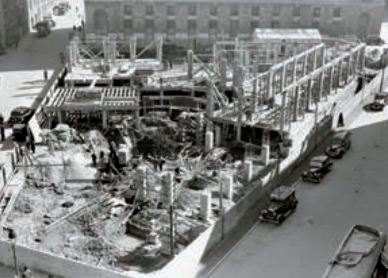
La Jirafa en construcción. (Año 1954)
